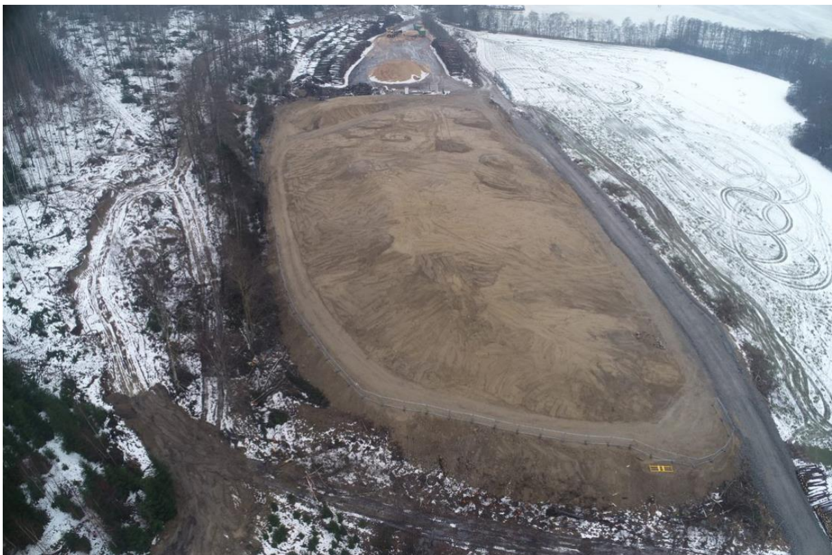
Figur 6 Avfallshögen efter utförd sandtäckning
